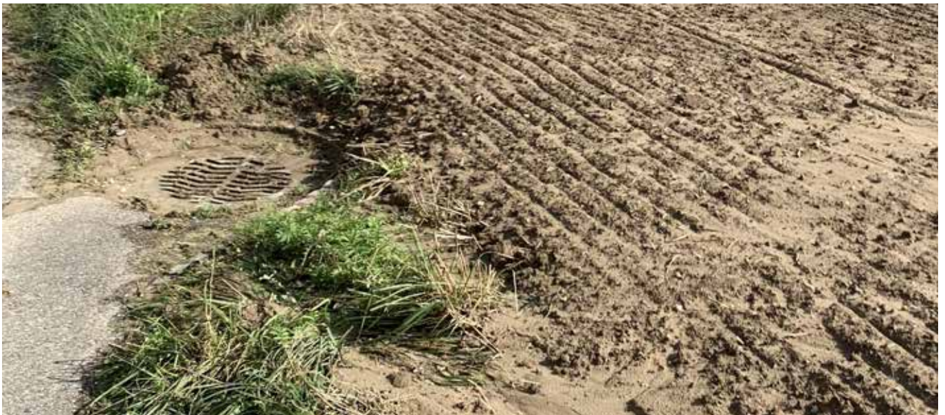
Abschwemmung in Schacht muss vermieden werden.
